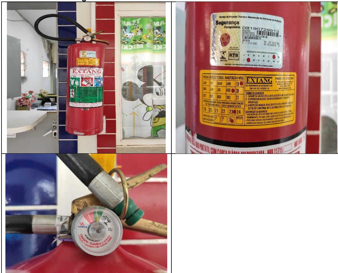
Tipo de Equipamento: Unidade extintora tipo água 2-A 10 L
